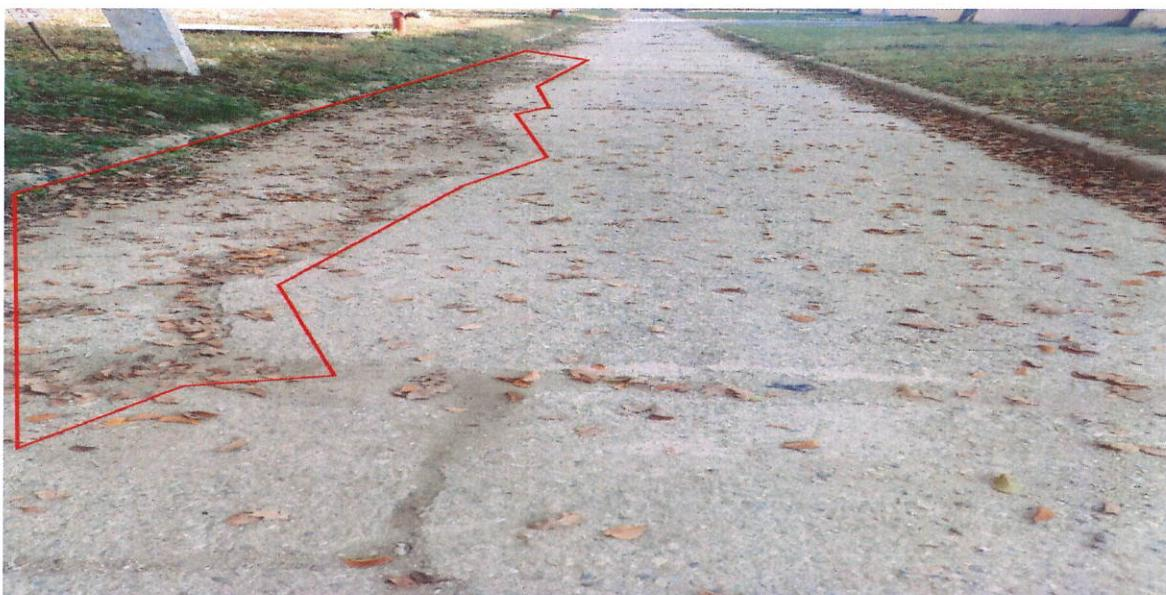
Se va proceda pentru zonele cu indice de degradare acceptabil, cca 75% din suprafata obtinerea sistemului rutier asa cum apare in NP116-2005,
