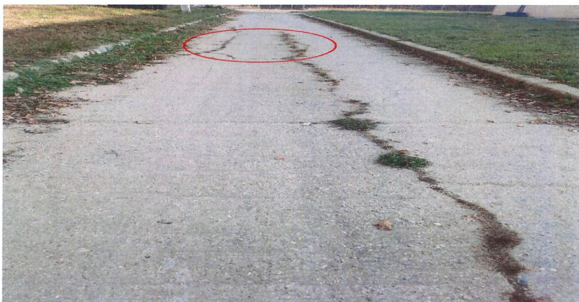
Structura rutiera existenta este cu imbracaminte rutiera rigida. Structura rutiera prezinta degradari specifice acestui tip de sistem rutier, de tipul cedari locale si fisuri izolate. In fotografiile prezentate sunt incercuite zone avand indicele de degradare  $I_c > 50\%$ . Acestea vor fi dezafectate si inlocuite cu materiale noi.
