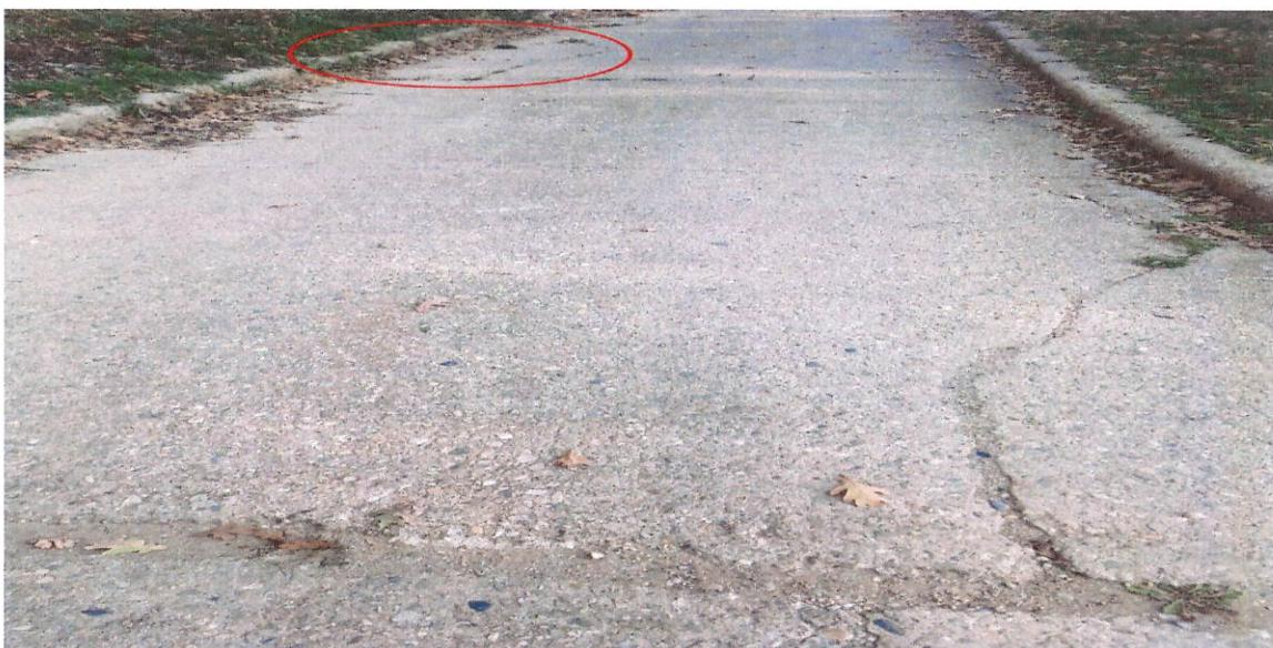
Expertiza interzice frezarea structurii existente, orice subiere a dalei de beton conducand la declasarea sistemului rutier in trotuar pietonal asa cum apare in NP116-2005, Anexa3, figura SRT-1, variante de alcatuire a structurii rutiere pentru trotuare.
